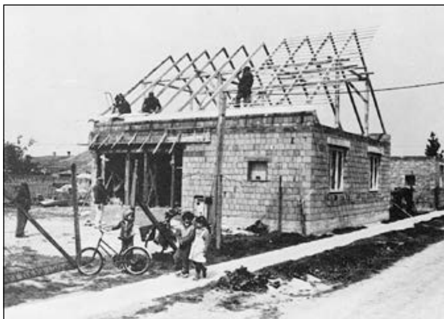
Budai Ignác Lakóházának építése a Bartók Béla u. 44. sz. alatt, 1984
